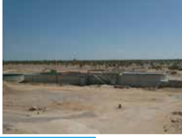
انجاز محطة معالجة المياه باجيم جربة بطاقة 10000 م 3 /يوم
