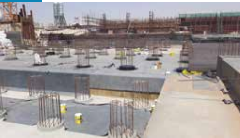
أشغال الهياكل الخرسانية للمباني
